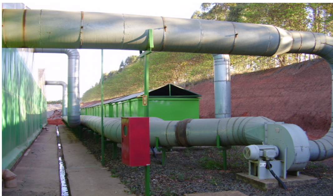
Vista externa (fundos) da Unidade de Biorremediação do CGR-Paulínia: Sistema de exaustão das emissões gasosas provenientes dos galpões. Podem ser observados os dutos de captação.
