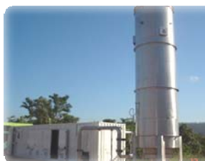
Vista da estação de queima dos gases coletados no maciço de resíduos sólidos.
