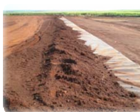
Detalhe do sistema de impermeabilização de base – camada de solo compactado sobre a geomembrana de PEAD.
