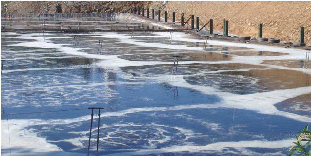
Vista de uma lagoa aerada e impermeabilizada.
