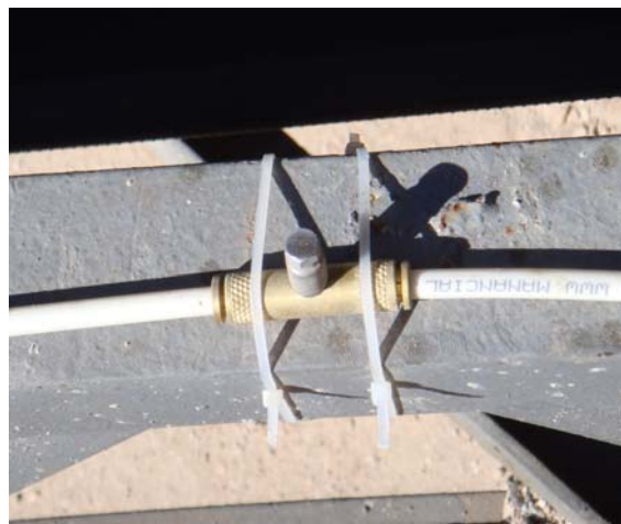
Detalhe de um bico de aspersão.
