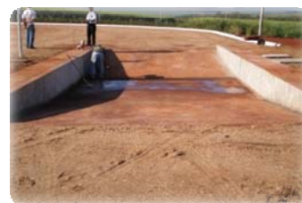
Vista do sistema de lavagem de rodas dos veículos transportadores de resíduos sólidos.
