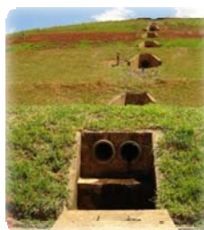
Sistema de drenagem de águas pluviais do aterro sanitário.
