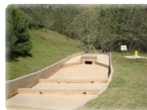
Sistema de drenagem superficial implantado no CGR-Itapevi
