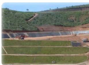
Vista parcial do empreendimento: células já encerradas, providas de elementos de drenagem de águas superficiais e de proteção dos taludes.
