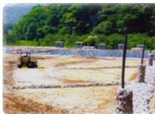
Sistema de drenagem de gases e de líquidos percolados, anterior à operação.
