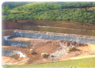
Detalhe da operação de cobertura dos resíduos com solo.
