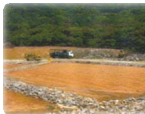
Drenos de líquidos percolados e camada de proteção da geomembrana de PEAD, anterior à operação.
