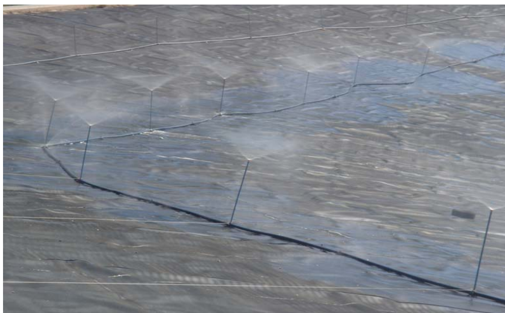
Sistema de aspersão em área impermeabilizada e sujeita aos raios solares.
